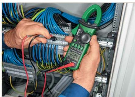
在开关柜中进行电流测量
