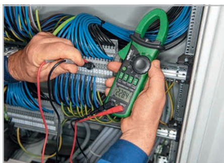
在开关柜中进行电压测量
