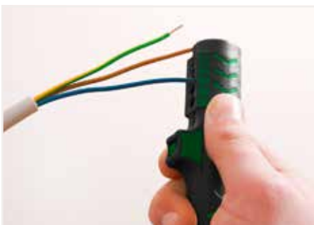
剥除导线绝缘层。
