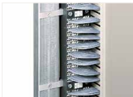
安装示例： 框架内的矩阵式接线端子
