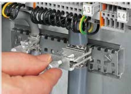
安装/拆卸屏蔽线连接器。
