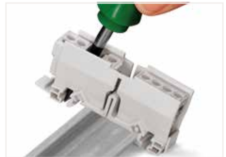
将固定支架从DIN导轨上拆下。
