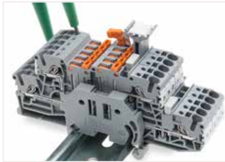
使用电压测试器进行测试。
