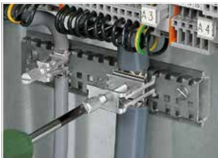
插入屏蔽线连接器后，拧紧滚花螺母即完成安装。 推荐螺丝拧紧扭矩：0.5 Nm
