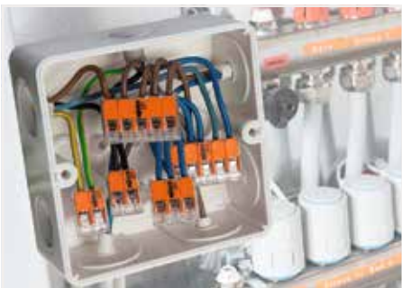
接线盒内的细多股导线布线，用于地暖系统。
