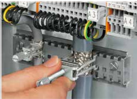
安装额外的屏蔽线连接器。
