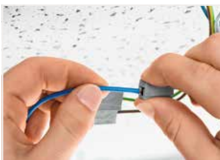
接线：将连接器上的按键压到底，导线即可插入方形孔中。
