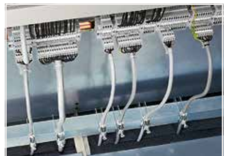
导线从底部进入电气柜，且具备独立的护线单元，电气柜有可移动的底板和橡胶密封装置，从而提供了IP54的防护等级(例如威图控制柜)。
