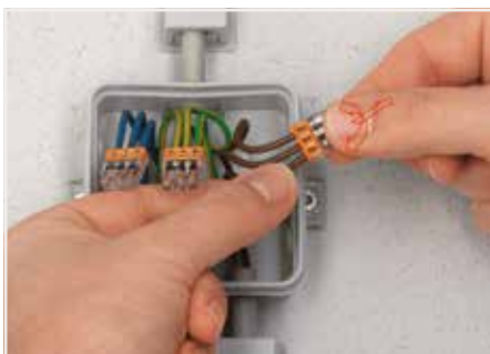
拆线操作：通过左右转动连接器即可将导线拔出。
