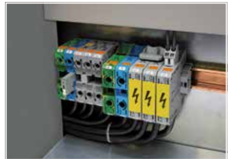
由于采取侧面接线的方式，即使是不易弯曲的较大截面积的导线也可轻松连接。
