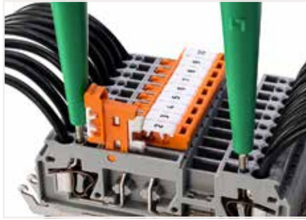
使用电压测试器进行测试。
