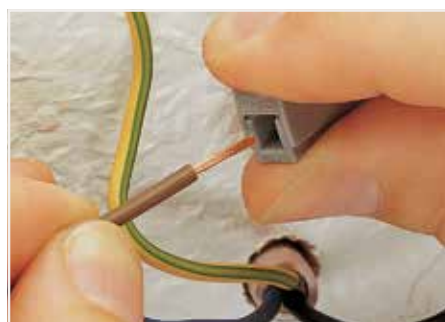
拆线：按压按键，然后抽出导线。
