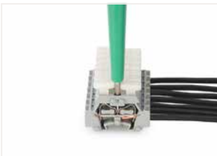
使用电压测试器进行测试。
