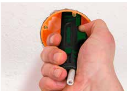
剥除线缆护层。
